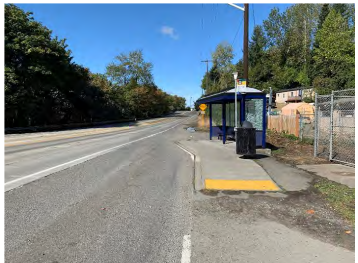
Parada de autobuses en la SR 900 al oeste de 68th Avenue South.
